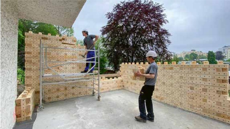
Produktion und Hausbau mit mikro-modularen BRIQs von TRIQBRIQ: Ein Holzbausystem für nachhaltigen Rohbau aus Schwach- und Schadholz aus regionalen Wäldern
